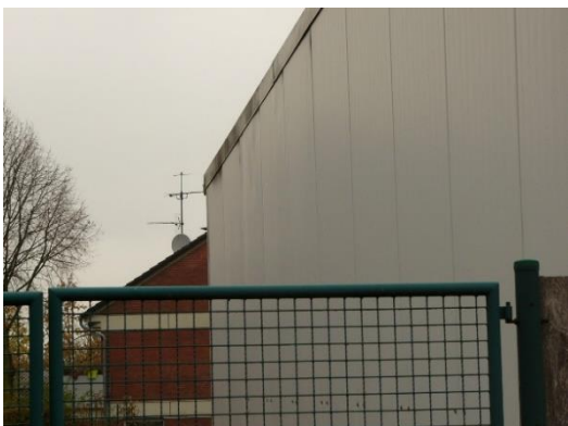
Abb. 7: Fassadenverkleidung und Attika des Auslieferungslagers -
