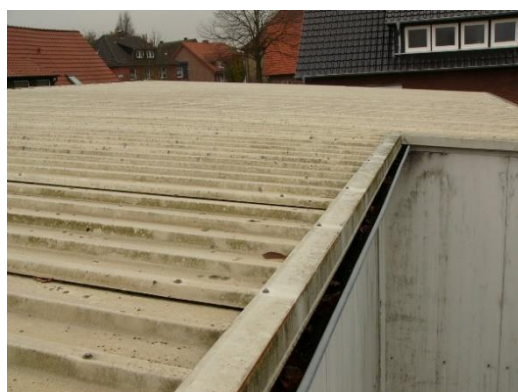
Abb. 8: Flachdach des Auslieferungslagers
