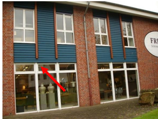
Abb. 2: Fassade Nordseite mit Rollläden
