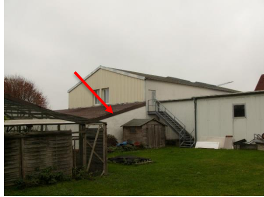
Abb. 10: Blick von Westen auf Gebäude 3 und 4 rechts
