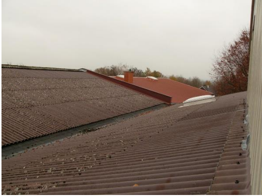
Abb. 9: Blick von Südwesten auf die Dächer von Gebäude 1 und Zwischenbau
